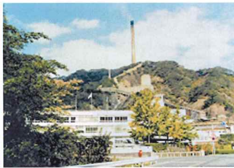
倒壊前の大煙突
