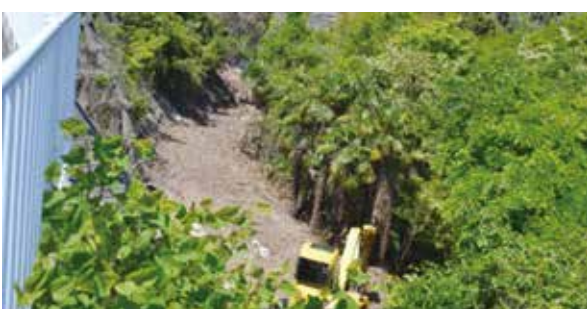
高松台地区→長年群生発達した竹林等の伐採除去
