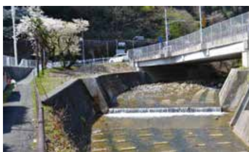
新町地区の堆積土石、雑木の処理
